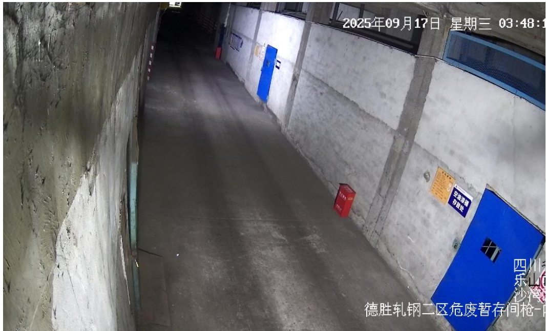
图 4-2 依托危废暂存间
