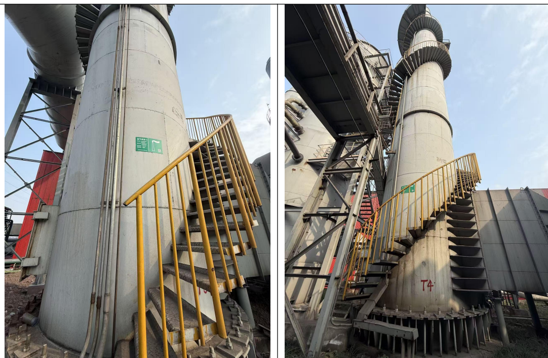
图 3-1 排气筒现场照片
